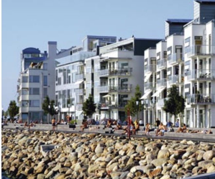
I samband med bostadsutställningen Bo 01 i Malmö byggdes 350 lägenheter i Västra hamnen. Trots att man här satsat på det mest moderna så har det missats en hel del när det gäller tillgängligheten. FOTO: TOMAS LUNDENMARK (även nedan).
